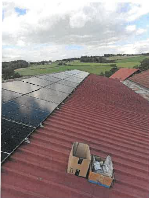
Installation de panneaux photovoltaïques
